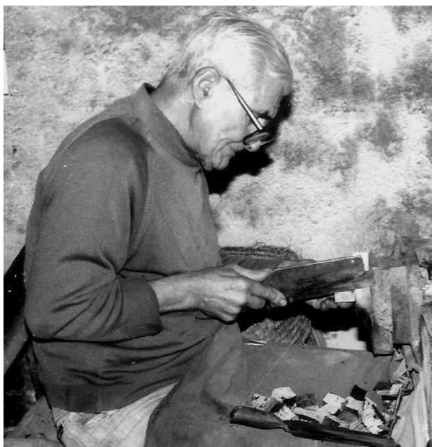
Antigo corticeiro da «Rovifer, Lda.» produzindo quadros de cortiça, com faca apropriada. Ano de 1991 (Foto Manuel Lima)
