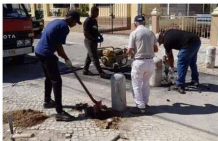
Recuperação e instalação de pilaretes vandalizados, por estacionamento abusivo em passeios.
